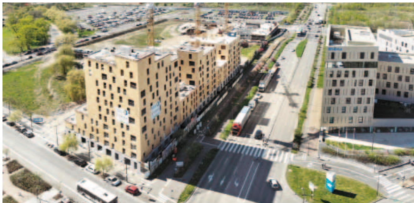
Sensations, un immeuble d'habitation en bois de 38 mètres de haut sur 11 niveaux, doit être livré cet été par Bouygues Immobilier à Strasbourg.
