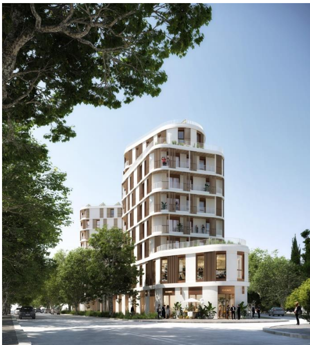
Immeuble « Flora », Nanterre (92). Pyramide d'Argent du Bâtiment Bas Carbone remis par la FPI. Prix de l'Immeuble le plus vertueux de l'année remis par le SIATI.
