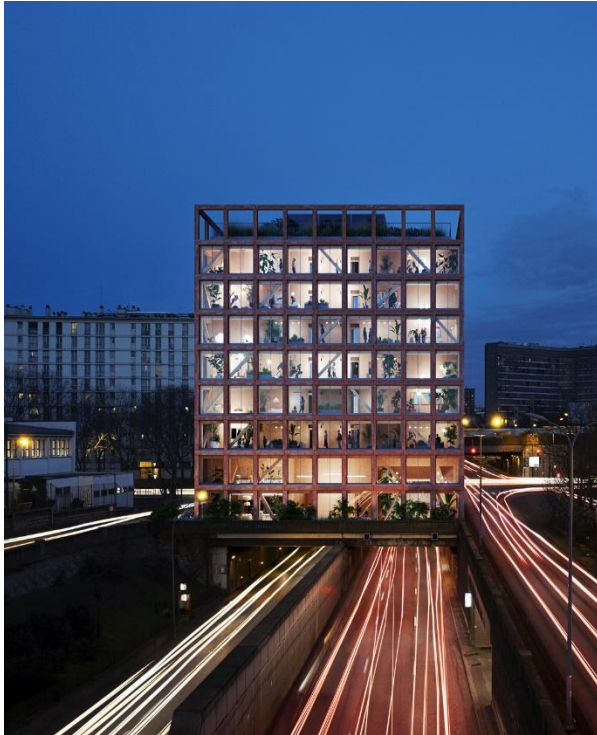
Immeuble « Hosta », Paris (75). Foyer pour jeunes travailleurs bas carbone conçu en bois massif situé Porte Brancion, au-dessus du boulevard périphérique parisien, à la jonction de Paris et Vanves. Projet issu du concours « Inventons la Métropole du Grand Paris » organisé par la Métropole du Grand Paris.
